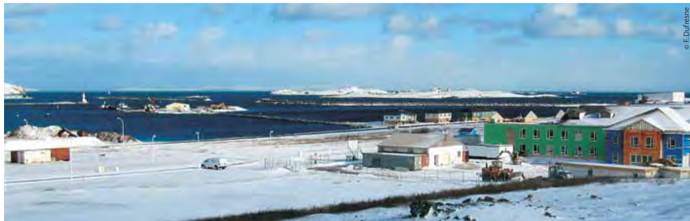
Saint-Pierre-et-Miquelon, construction du nouvel hôpital public
