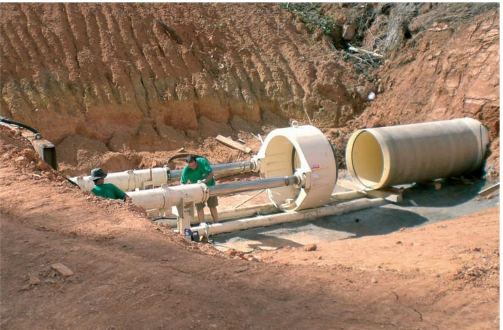
Fonçage d'ouvrage hydraulique sous la RN1 – *DDE*
