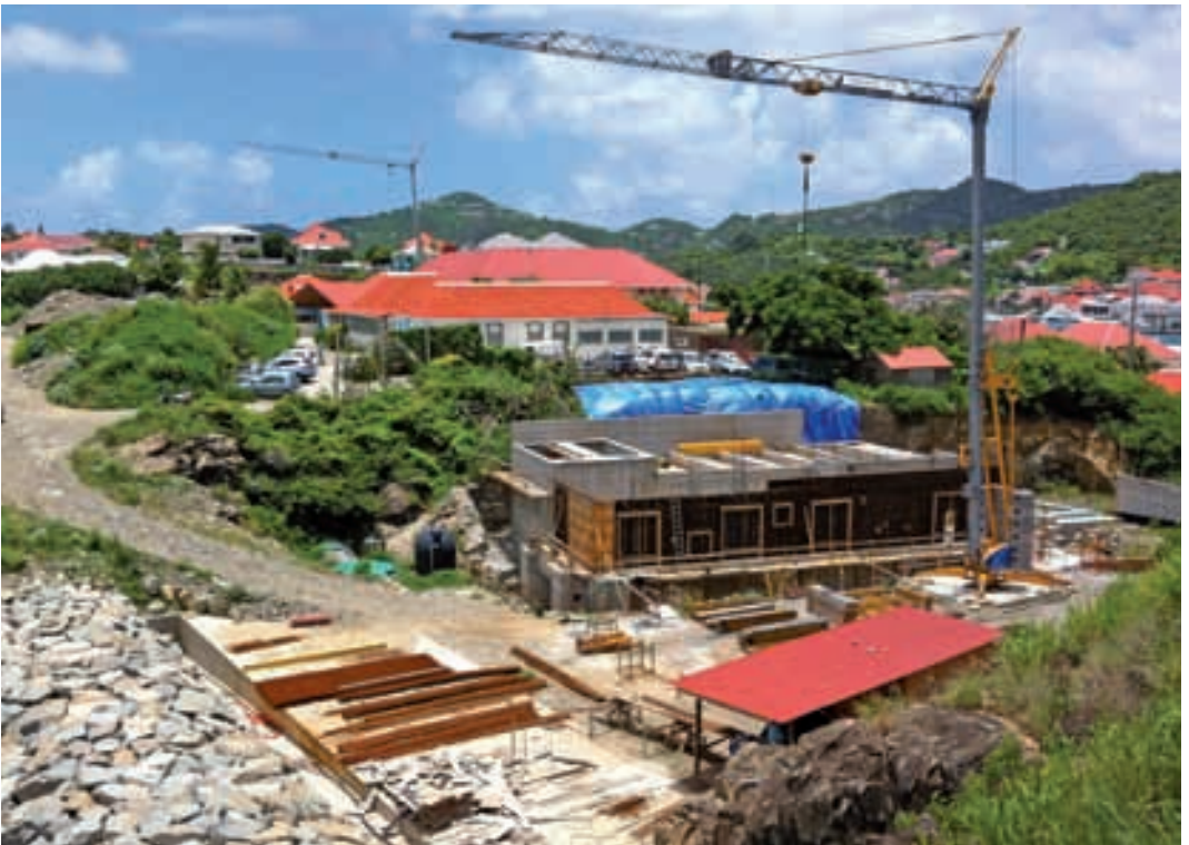
Chantier de la station d'épuration - © M. DESOUCHES
