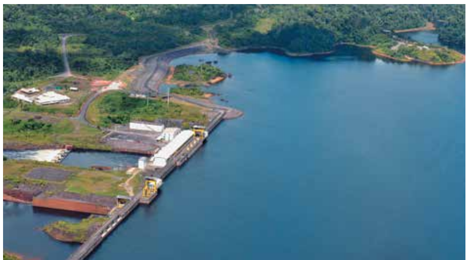
Guyane. Barrage de Petit-Saut. © EDF
