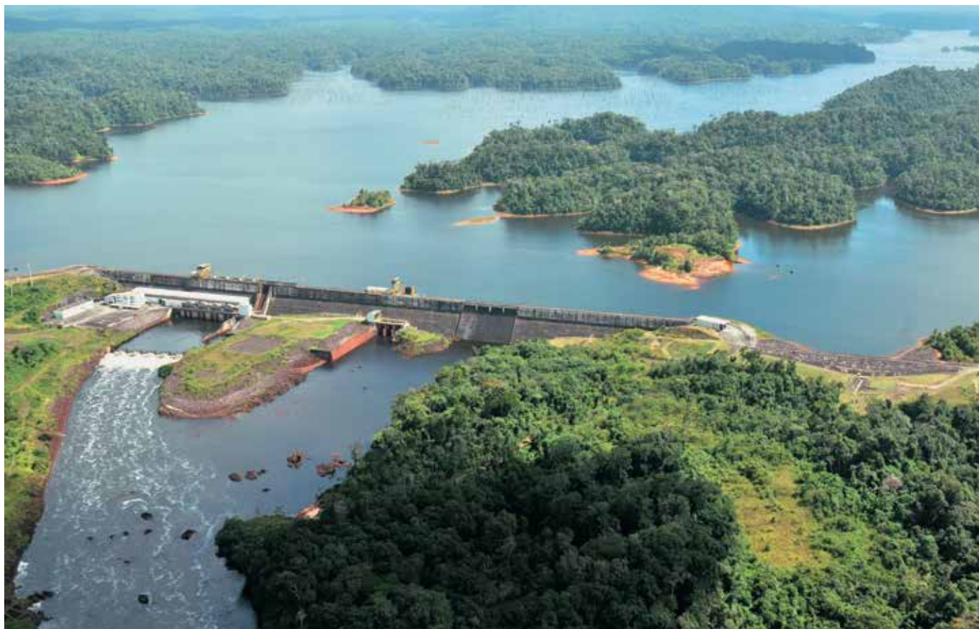
Guyane. Barrage de Petit-Saut. © EDF
