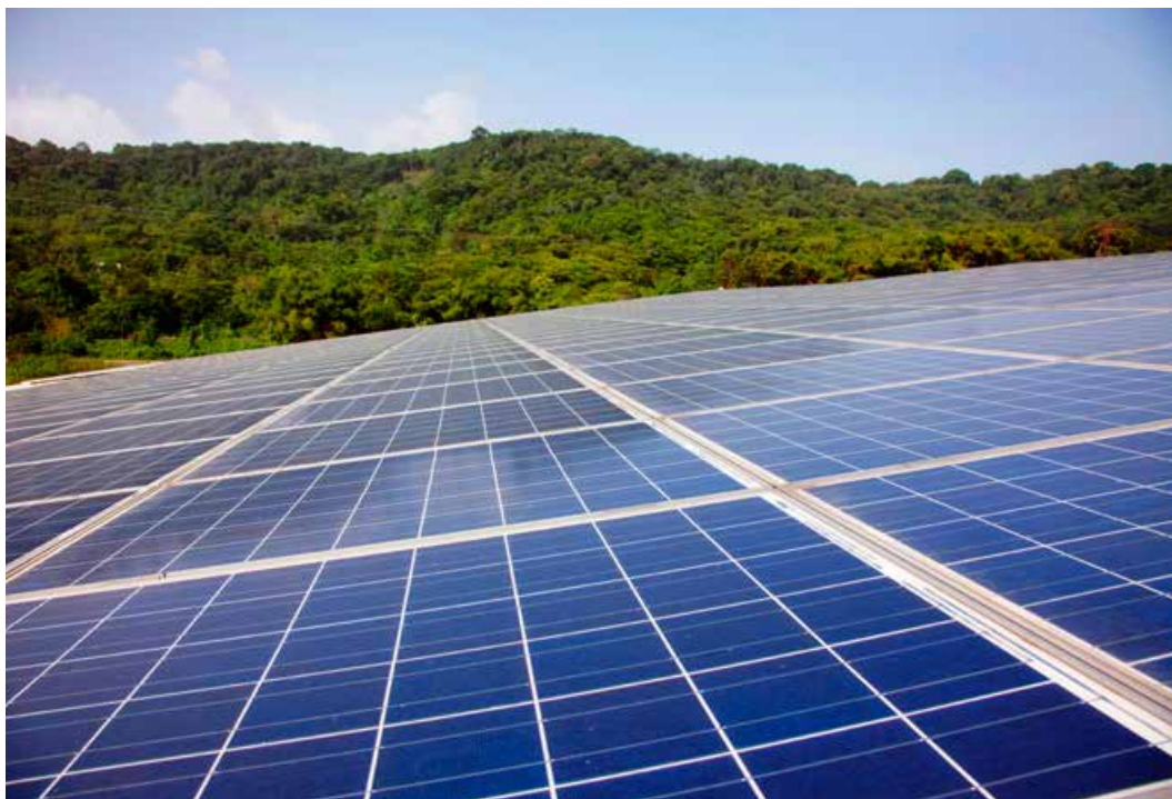
Generateurs photovoltaïques © ADEME - Ronan Liétar
