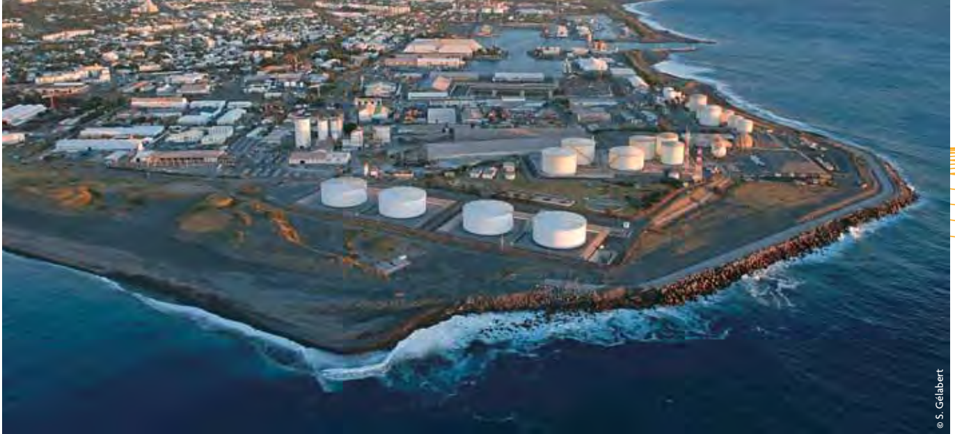
La Réunion, terminal pétrolier de la SRPP au Port
