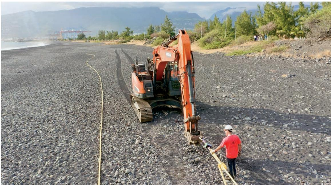
La Réunion. Travaux pour la pose du câble de fibre optique METISS. © ZEOP\_Serge Marizy
