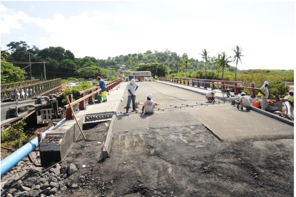
Construction du pont de Kwalé (AFD)
