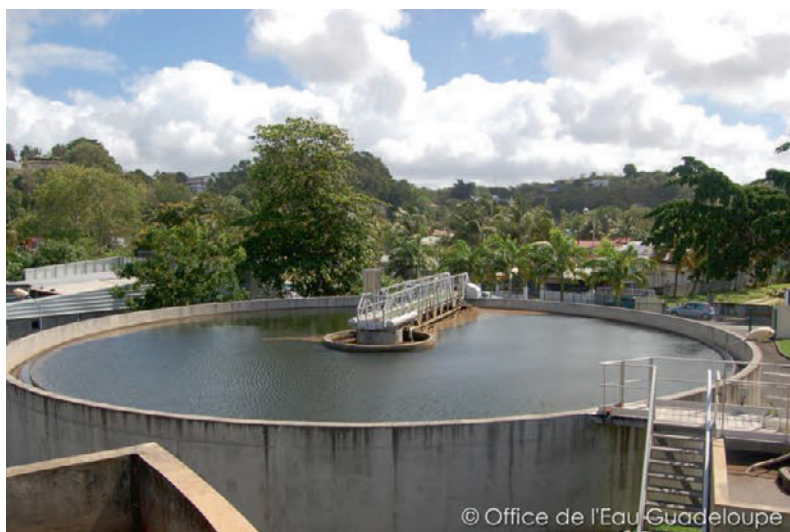
Station d'épuration en Guadeloupe © OFFICE DE L'EAU DE GUADELOUPE
