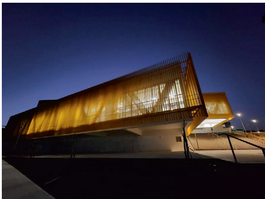
Nouveau restaurant scolaire du lycée Baimbridge © ICM
