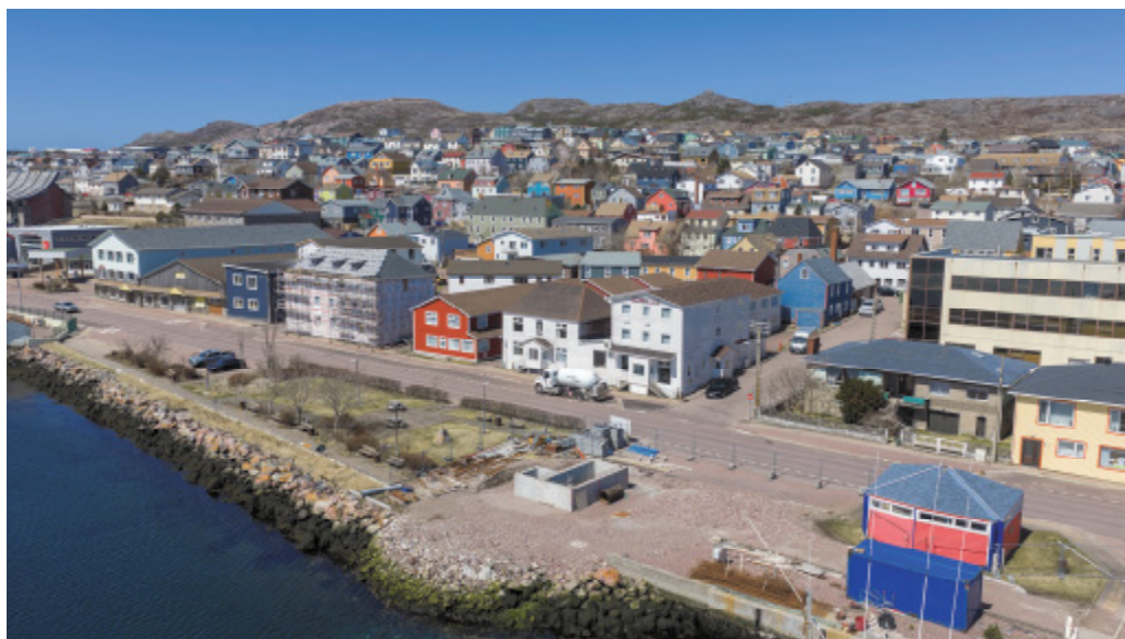
Construction des stations de refoulement des eaux usées à Saint-Pierre © Jaimespm'prod
