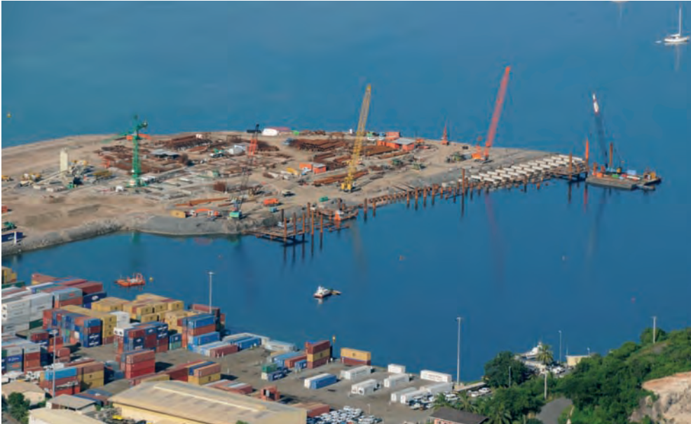
Chantier de construction du second quai du port de Longoni (Photo : D. Herrmann - LNDM)
