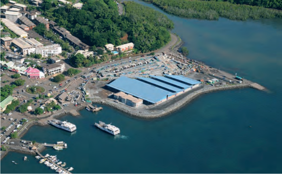
Chantier, en voie d'achèvement, du nouveau marché de Mamoudzou. (Photo : D. Herrmann - LNDM)
