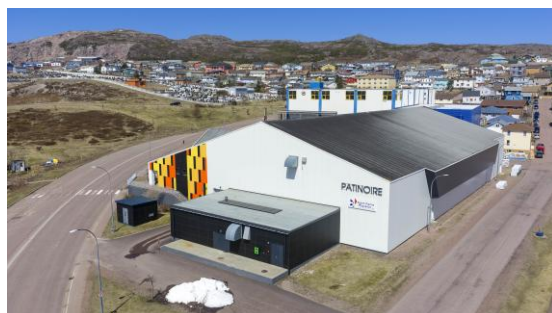
Panneaux solaires sur la patinoire de Saint-Pierre © Jaimesp/prod
