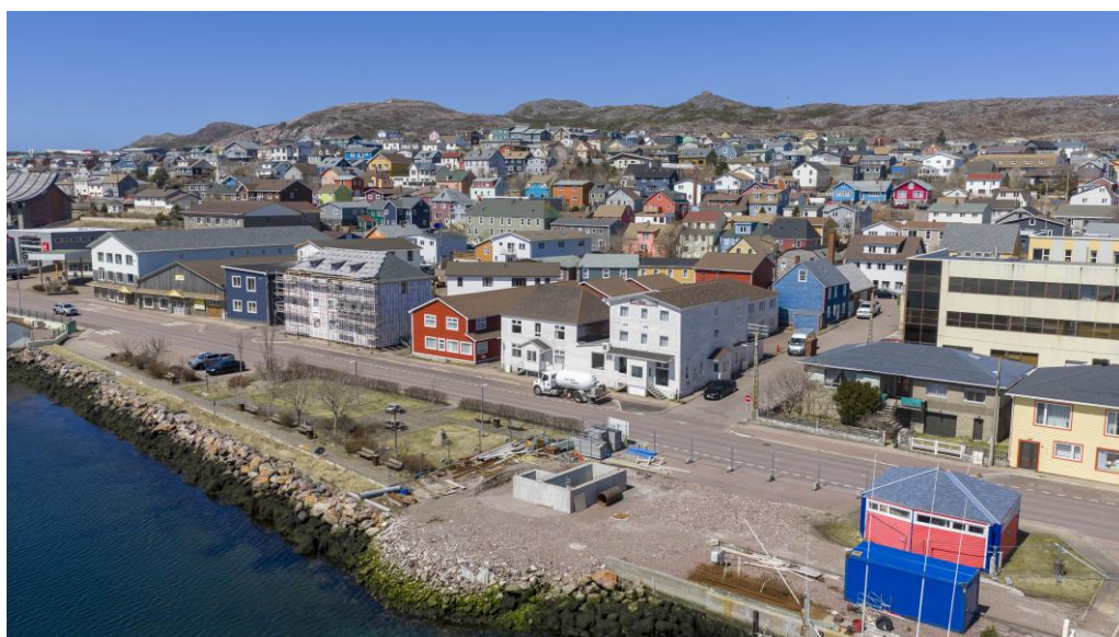
Construction des stations de refolement des eaux usées à Saint-Pierre © Jaimespm'prod
