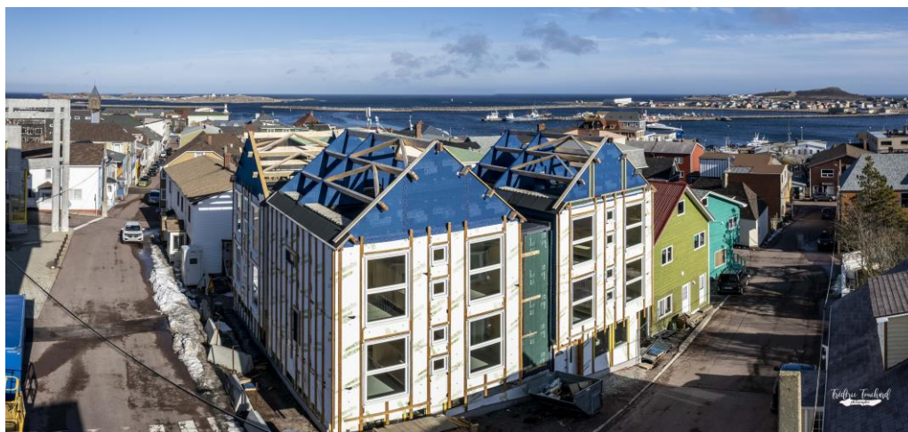
Construction du nouvel internat de la réussite © Jaimespm'prod
