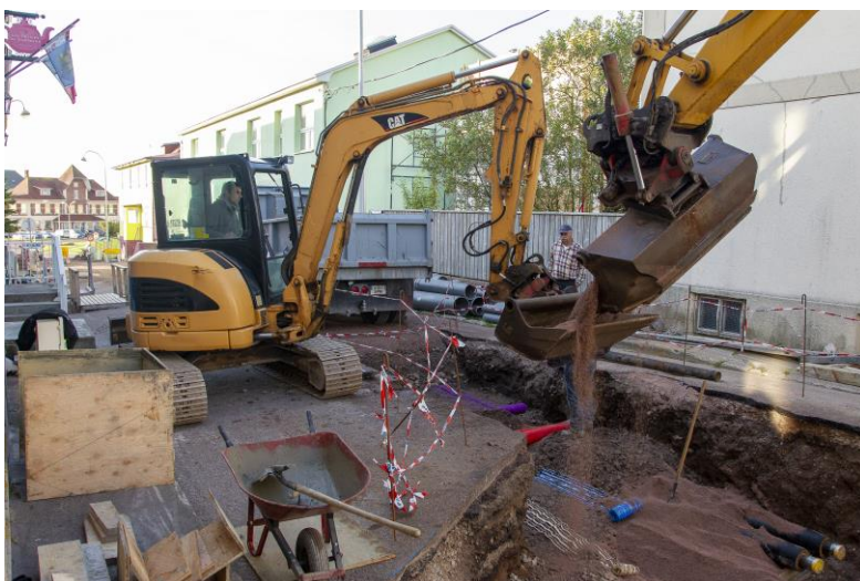
Travaux pour le passage du réseau de chaleur © Chantal Briand
