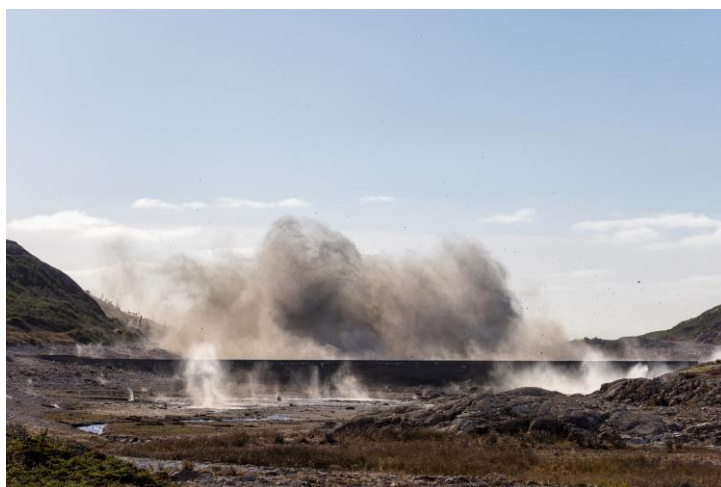
Destruction du barrage de la Vigie © Chantal Briand
