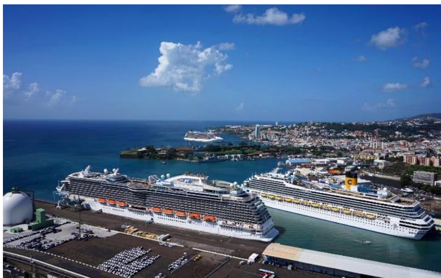
Terminal de croisières à Fort-de-France © Le Grand port Maritime de la Martinique
