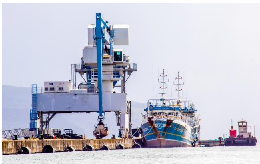
Installations portuaires du GPMLM © Le Grand port Maritime de la Martinique
