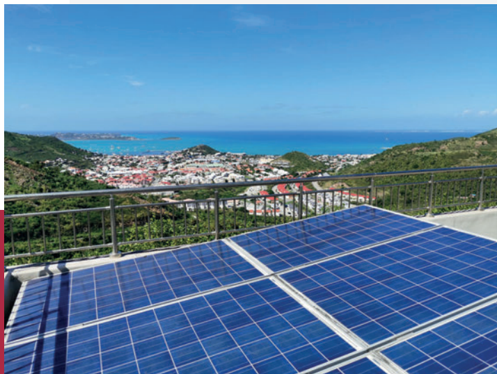
Panneaux photovoltaïques sur la Citerne de la SAUR à Concordia @Philippe GUISTINATI Société ENERGY SOLAR SXM
